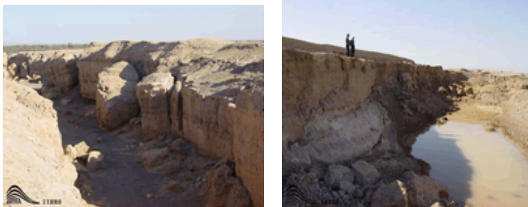
شکل ۱۲ نمونه‌هایی از فرسایش عمیق خندقی
